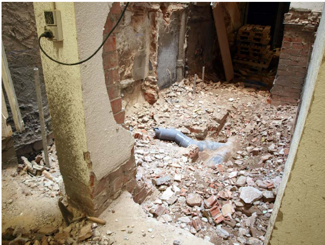
Foto 19 : Zona on estaven ubicats dos sondejos més, molt malmesa per intervencions del subsòl durant el segle XX.
