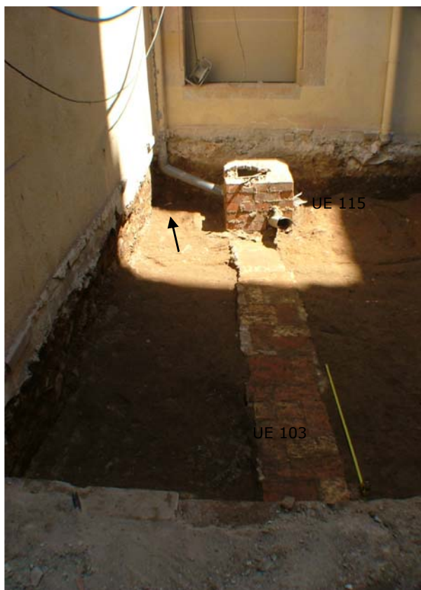
Foto 1 : Claveguera UE 103 i arqueta UE 115
